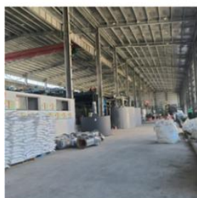
一期工程现场全貌
